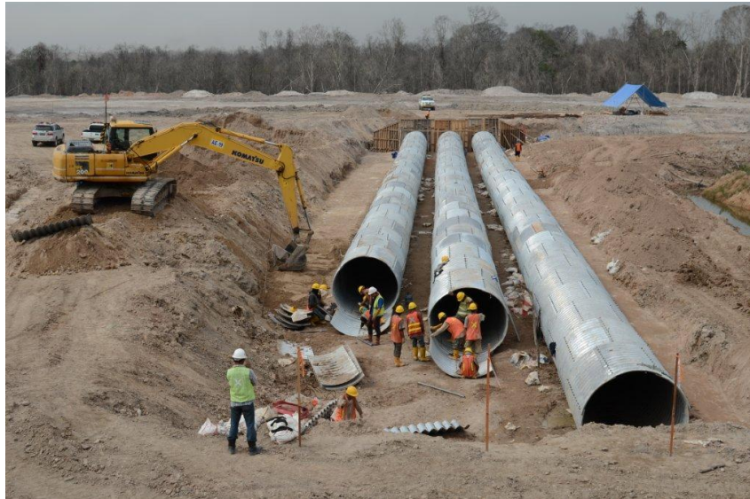
Bahan-bahan multi plat untuk gorong-gorong telah dikirim ke Pit dan pemasangannya saat ini sedang berjalan
